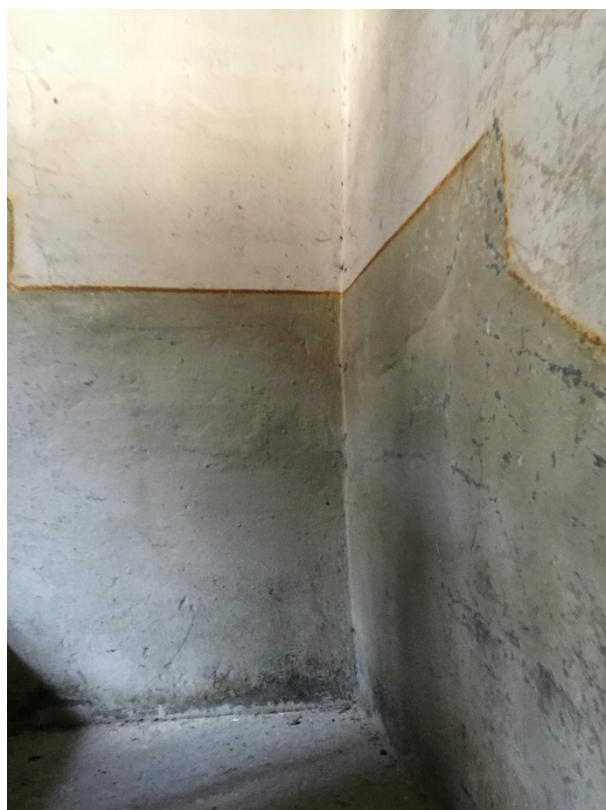
Foto 8 finto zoccolo con filetto terminale sulle scale, con funzione decorativa e anche di protezione al passaggio
