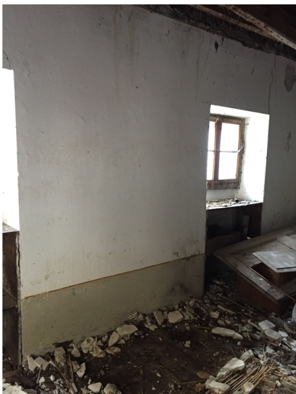
Foto 7 parete intonacata con tinteggio alla calce chiaro e zoccolo e filetto.
