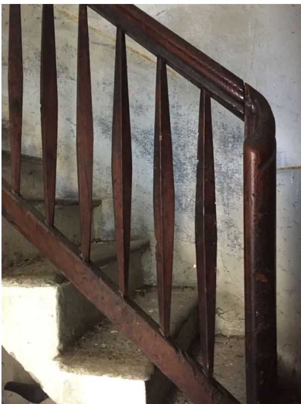
Foto 11 scale in pietra con zoccolo decorato. Corrimano molto elegante, in legno, con elementi sfaccettati e particolari della ringhiera. Impugnatura originale e curvatura finale.
